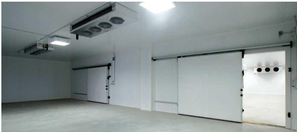
Una camera frigorifera è composta da pannelli coibentati (schiuma rigida in poli-isocianurato) con incastro maschio/femmina tenuti assieme da carpenteria metallica, profili in alluminio o lamiera verniciata e rivetti. Il tutto va a formare una struttura ermetica, solida e resistente.
