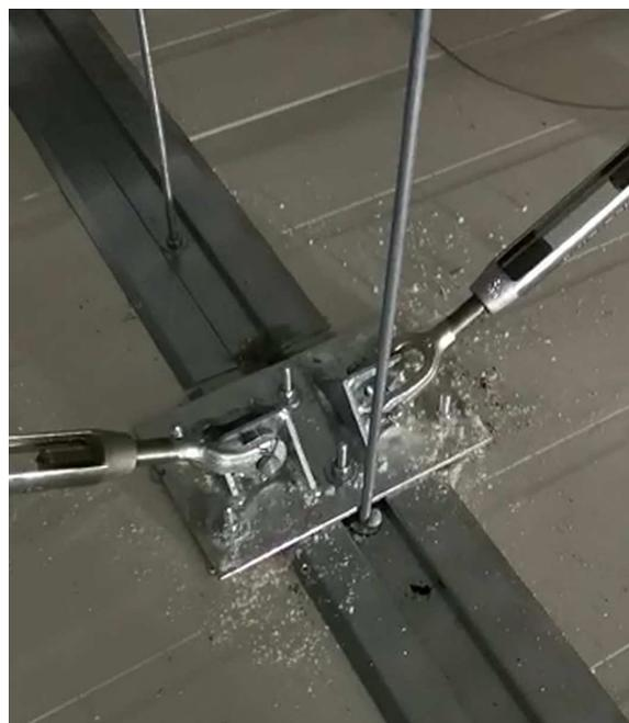
Poiché i controventi sono dei “fili” metallici soggetti ad instabilità in caso di azione di compressione, il modello prevede che solo il controvento in trazione collabori alla rigidità laterale.
